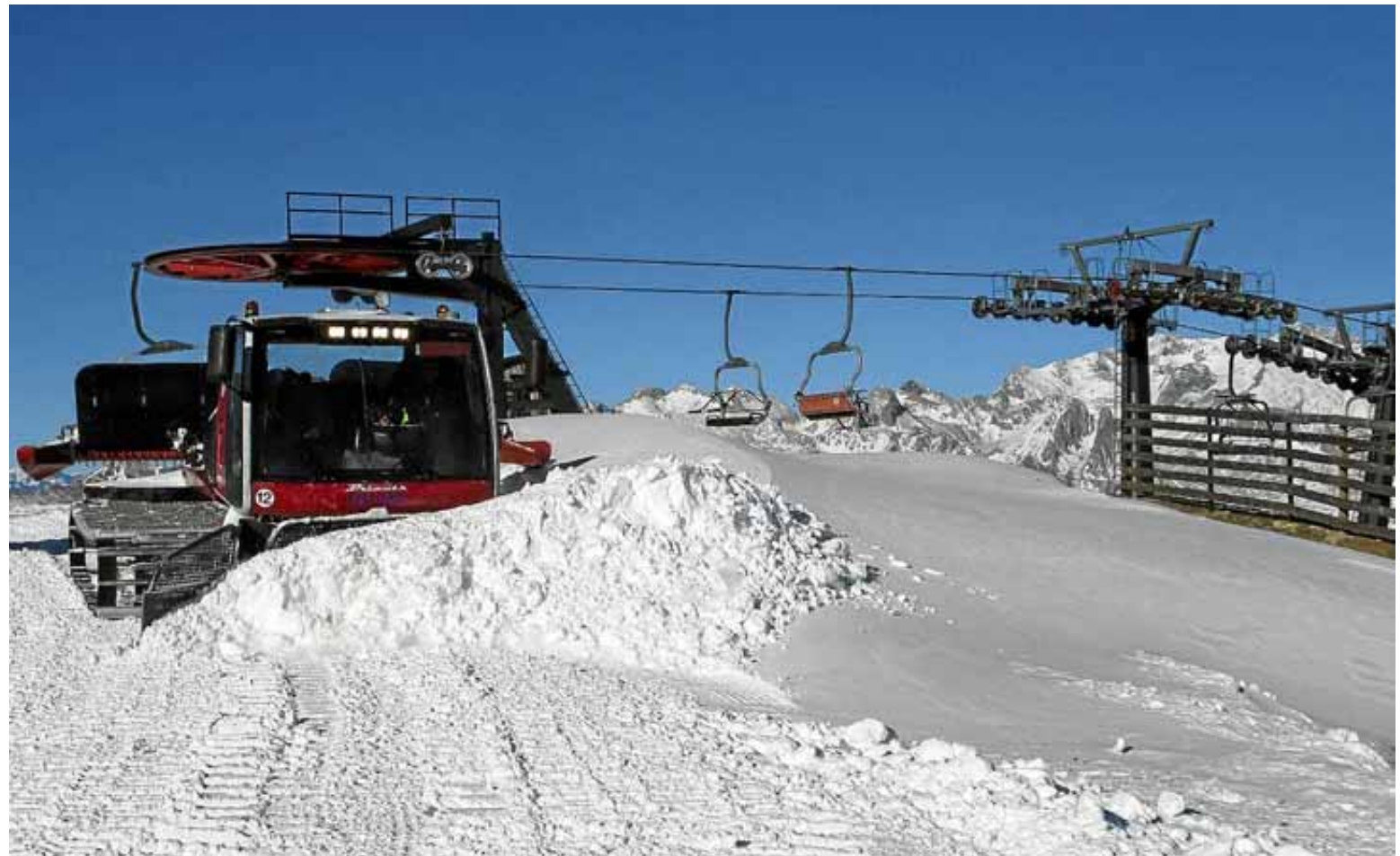
Las máquinas no cesan de trabajar para preparar las estaciones para su apertura. En la imagen, en las pistas de Cerler. ARAMÓN CERLER
